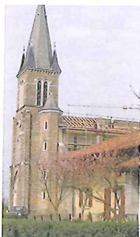
Restauration de l'église
