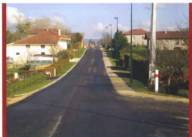
Février 2010 - Depuis le pont du Sevron après travaux
