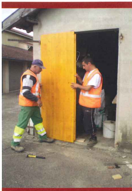
22 juin 2008 - Changement des portes du local technique place de l'église
