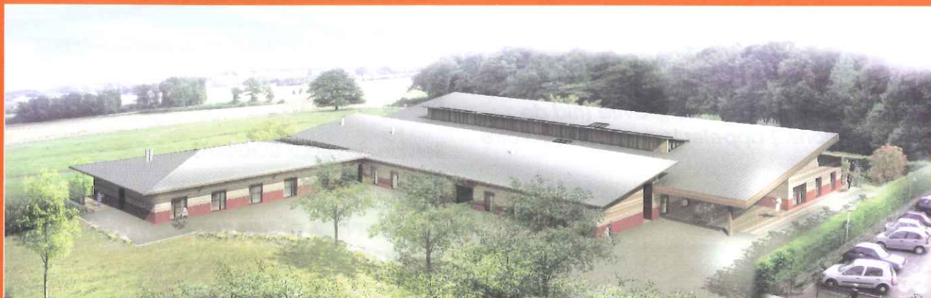
Vue de l'extension depuis le 2ème étage du bâtiment existant
