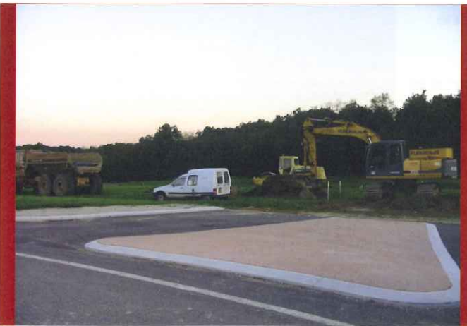
25 octobre 2006 - Le chantier débute
