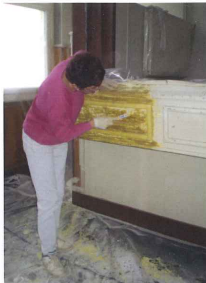
Janvier-Février 2008 - Rafraîchissement des murs et plafond de la salle des fêtes par les employés communaux - A chacun sa tâche !
