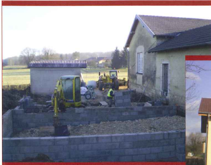
20 février 2009 - les travaux d'extension viennent de débuter.
