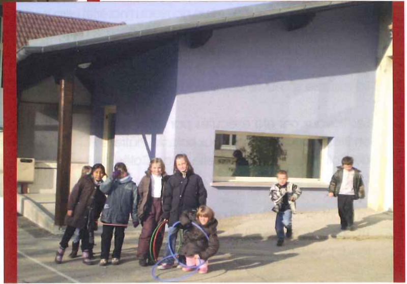
Auvent après travaux, le 17 décembre 2009.
