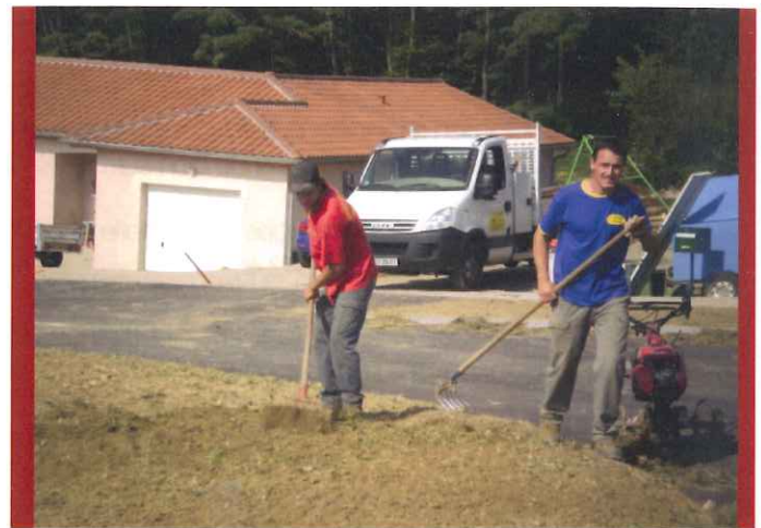
23 septembre 2009 - Préparation des espaces verts par l'entreprise Delay-Moiraud
