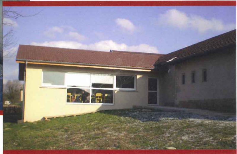
Décembre 2009 - la nouvelle salle de classe.
