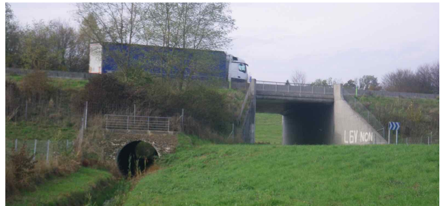
Passage à faune n°3
