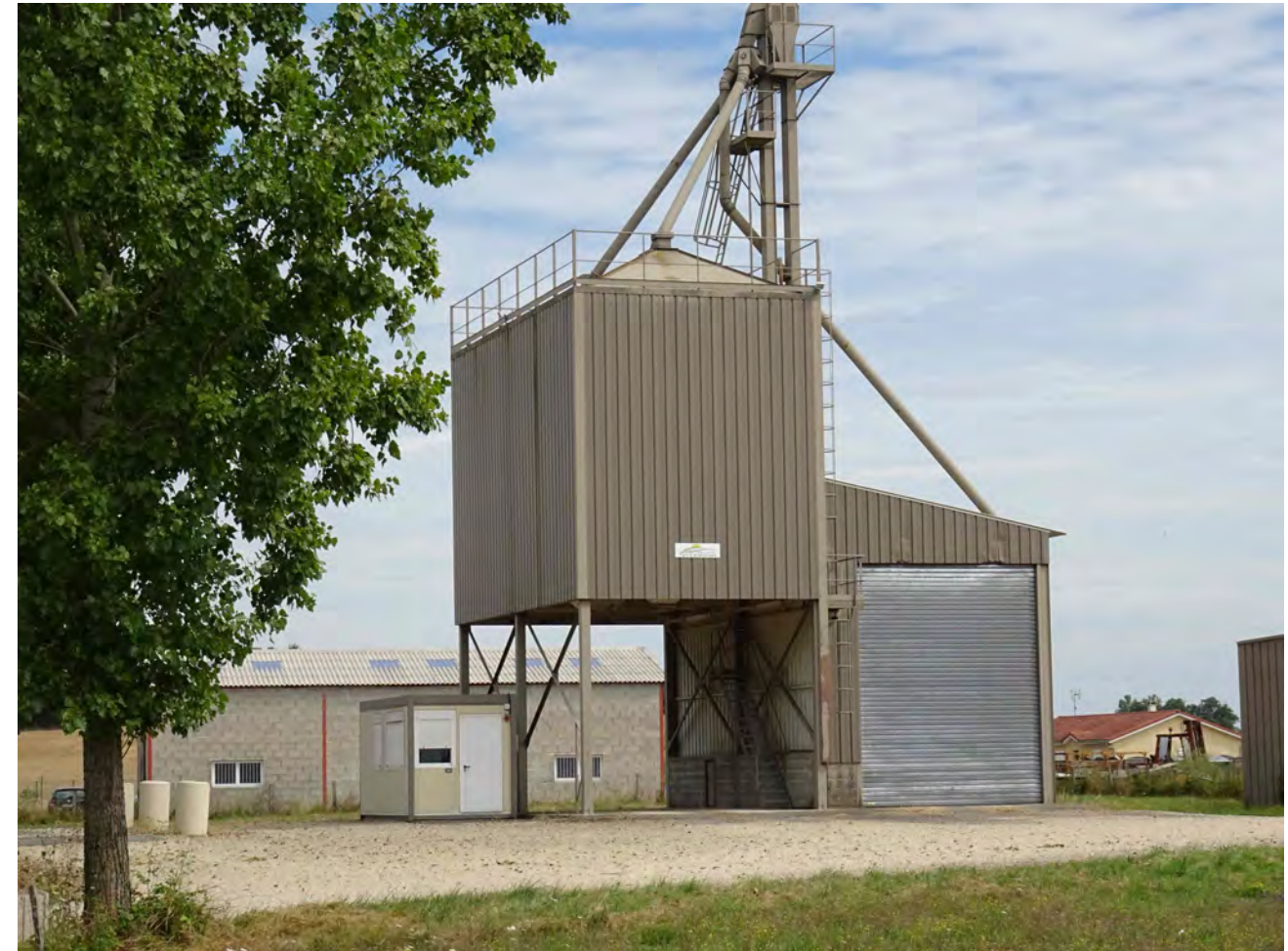
Silo en entré ouest du bourg à proximité des lotissements en arrière plan
