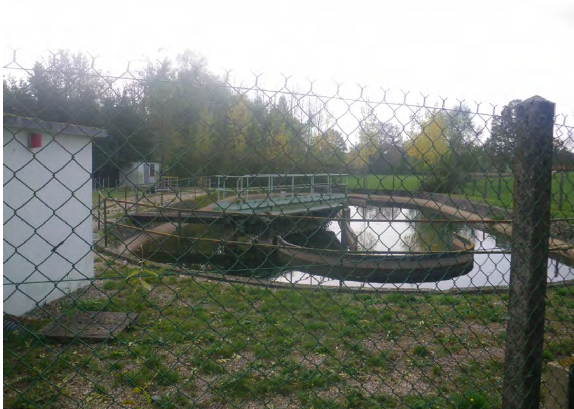
Station d'épuration de Beaupont, crédit photo : Mosaïque Environnement.
