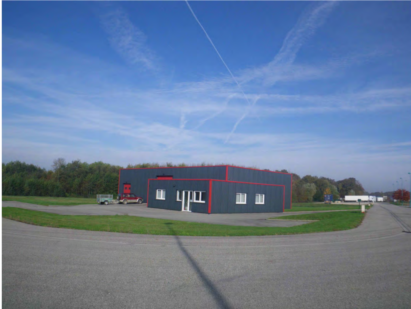
ZA du Biolay, la lagune se situe à droite du bâtiment au premier plan et le bassin de gestion des eaux pluviales se situe au niveau du container bleu en arrière plan, crédit photo : Mosaïque Environnement.
