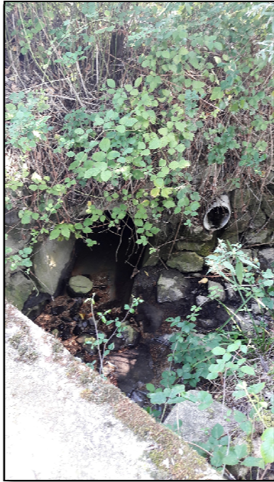
Vue amont – Arrivée du Ø800mm EP
