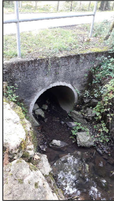
Vue aval de l'ouvrage hydraulique
