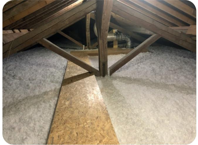
En amont de la pose de l'isolant, les employés communaux Jean-Luc et Johan ont installé des cheminements pour accéder aux VMC ainsi qu'à l'horloge de la salle des fêtes.
